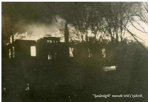
Brand in gebouw aan de westzijde op 8 december 1965.
